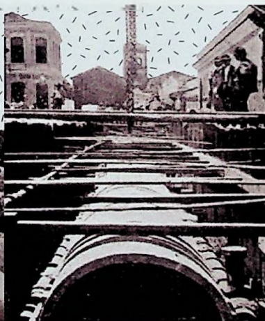
FIGURA 8. Obras da canalização do Ribeirão do Itororó. Fonte: SANTOS, 2012.
